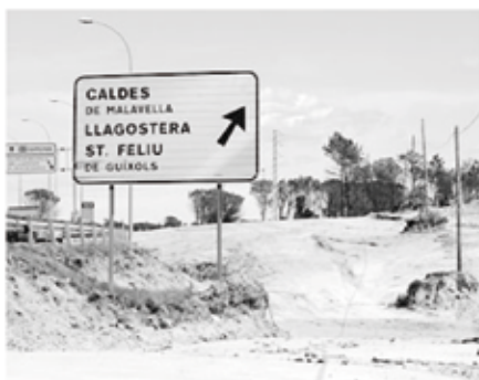
Les obres de desdoblament de l'N-II. EL PUNT
